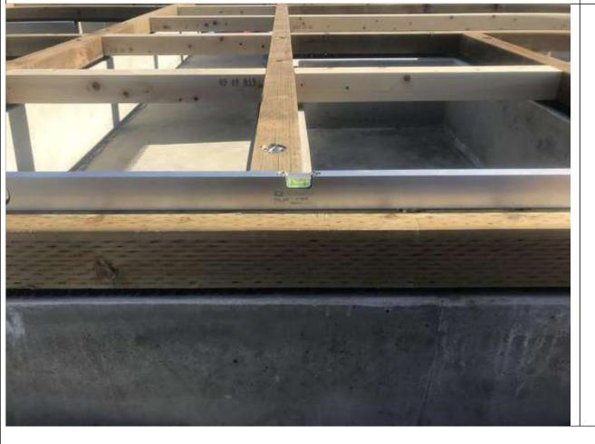
1-4口基礎パッキン・気密パッキン同士の隙間がないように敷き詰め、土台とパッキンの芯を一致させる。
