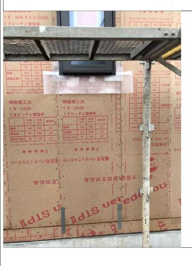
1-11 外壁下張りの釘のめり込み具合2mm以内か確認する。 ※デプスゲージ にて沈み込みの確認。
