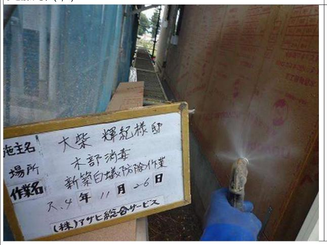
1-7口地面からの高さが1m以内の外壁の枠組の防腐・防蟻措置を現場で塗布・吹付をする。(1/4)
